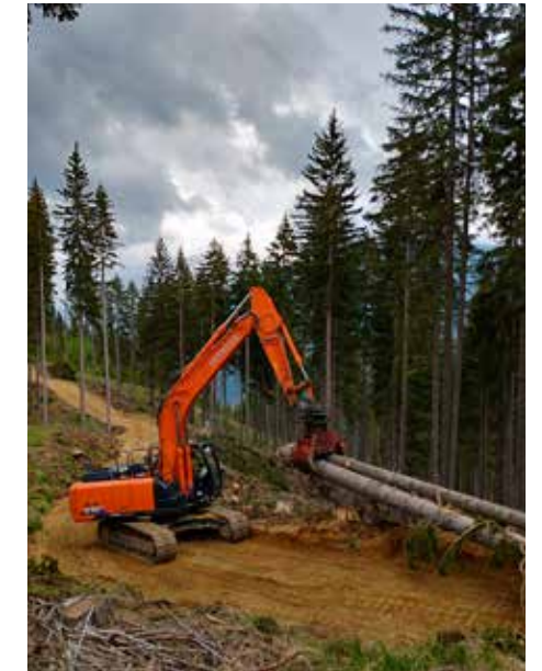
Wegbau Peischlacher Berg
