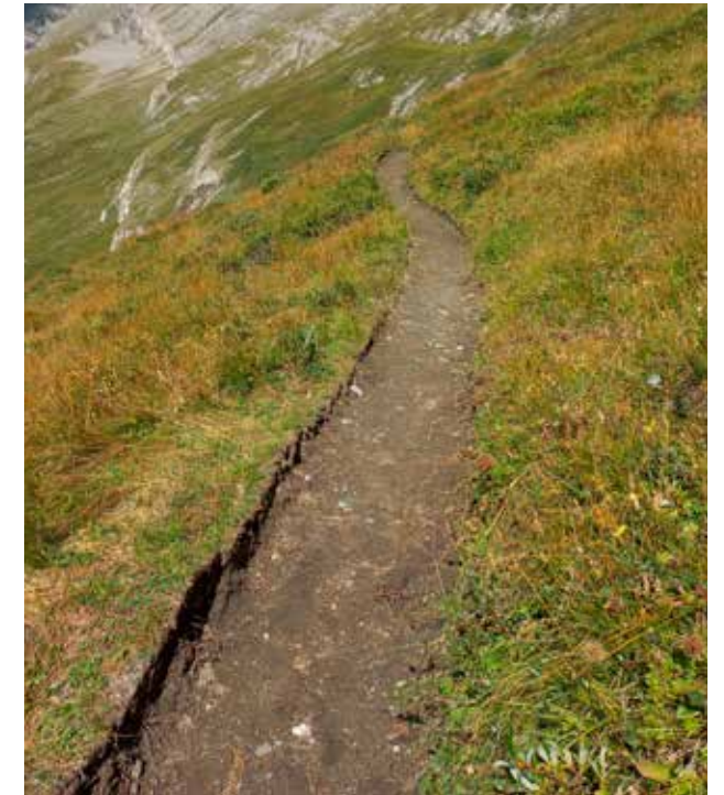
Der sanierte Weg
