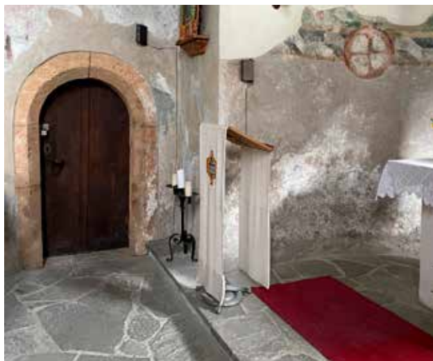
Sanierung St. Georg
