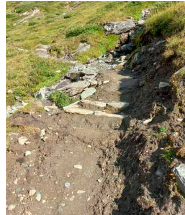
Steinstufen zur Befestigung
