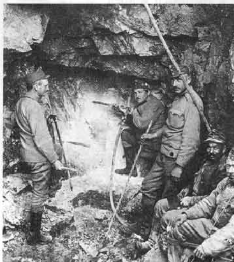
Mai 1916: Spreng- und Bohrarbeiten in einer Kaverne. Ein typisches, von der der Kriegspressestelle in Wien veranlaßtes Foto: Bilderbuchartig, idealgesehen. Die Wirklichkeit war ganz anders. Nur selten standen Preßluftgeräte z.B. zu Verfügung.
