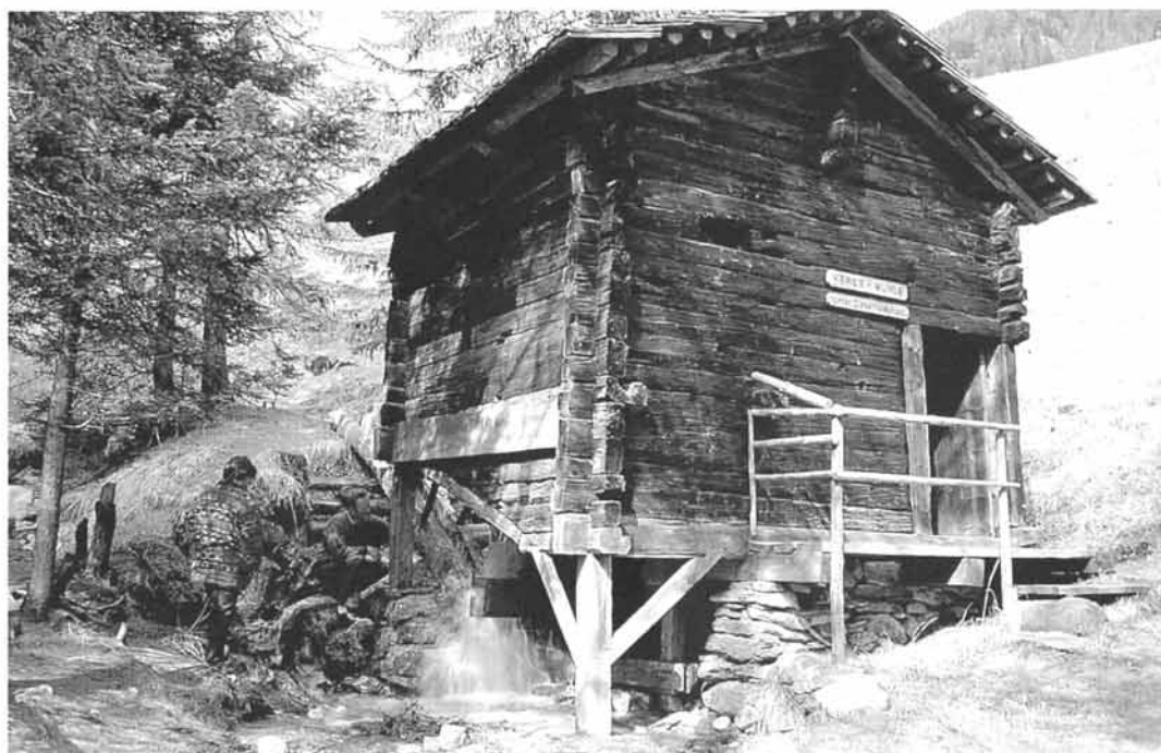
Die "Kerer - Mühle", typische Bauart der Stockmühle in Kals.
