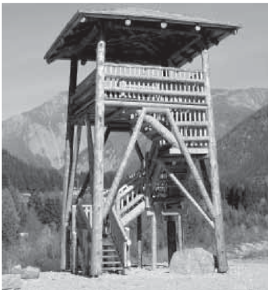
Der 9 Meter hohe Aussichtsturm: Von der 5,25 m hohen Plattform bietet sich ein schöner Überblick, und man kann sich auf Schautafeln über die getroffenen Maßnahmen informieren.
