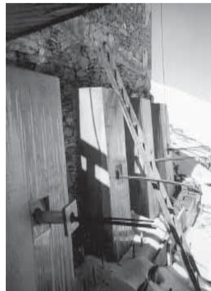
**Stahlbetonbalken dienen der Stabilisierung des Felsuntergrundes**
