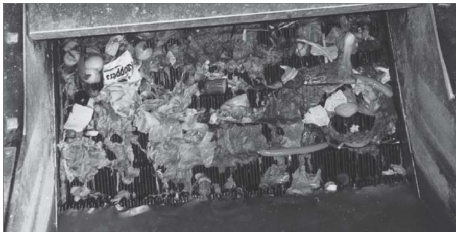
Grobstoffentfernung durch den Rechen im Kanaleinlauf der Kläranlage Huben-Kienburg. Anhand dieses Bildes ist zu ersehen, was über den Kanal entsorgt wird. Ein kompletter Menüplan ließe sich zusammenstellen.
