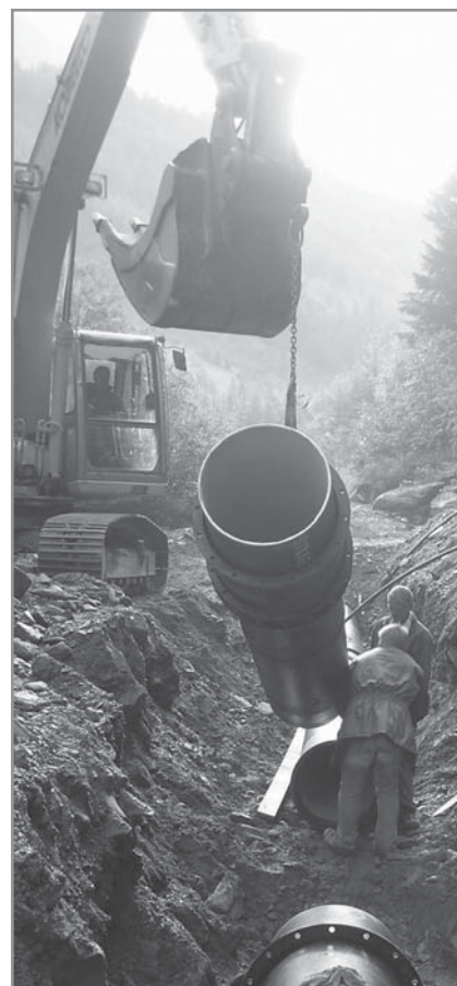
Zusammenschluss [Hochzeit] der Rohrleitung am 12. August 2005
