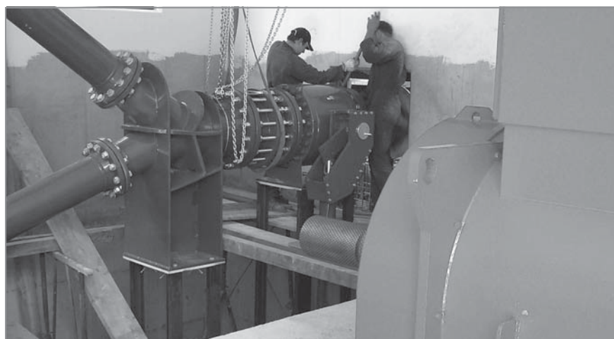
Mitarbeiter der Fa Tschurtschentaler bei der Montage des Hosenrohres im Krafthaus. Rechts der 9 to schwere Generator
