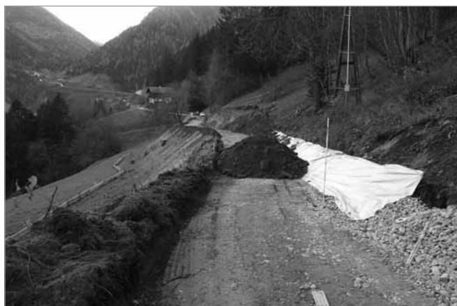
Umfangreiche Böschungsaufbauten, Frostkofferschüttung, Drainagierungen
