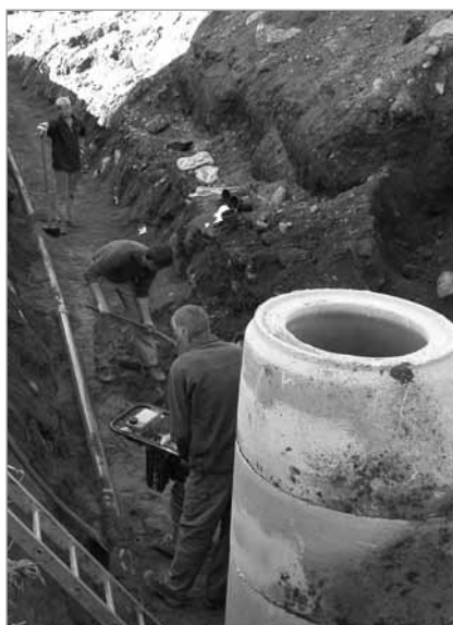
Kanalerschließung für Bauplätze in Glor-Berg/Ködnitz.
