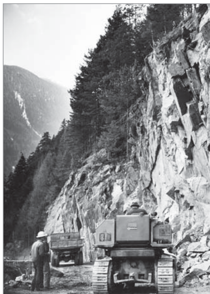
Straßenbau am Peischlacher Berg
