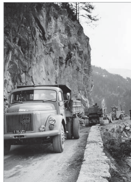
Straßenbau am Peischlacher Berg
