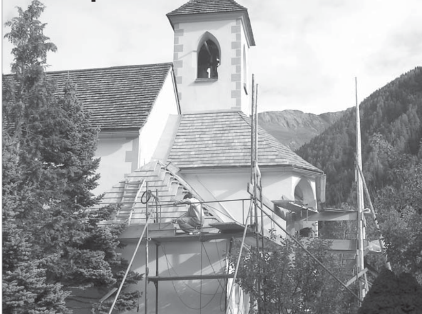
Dachrenovierung bei der Peternale [St. Petronilla in Großdorf]
