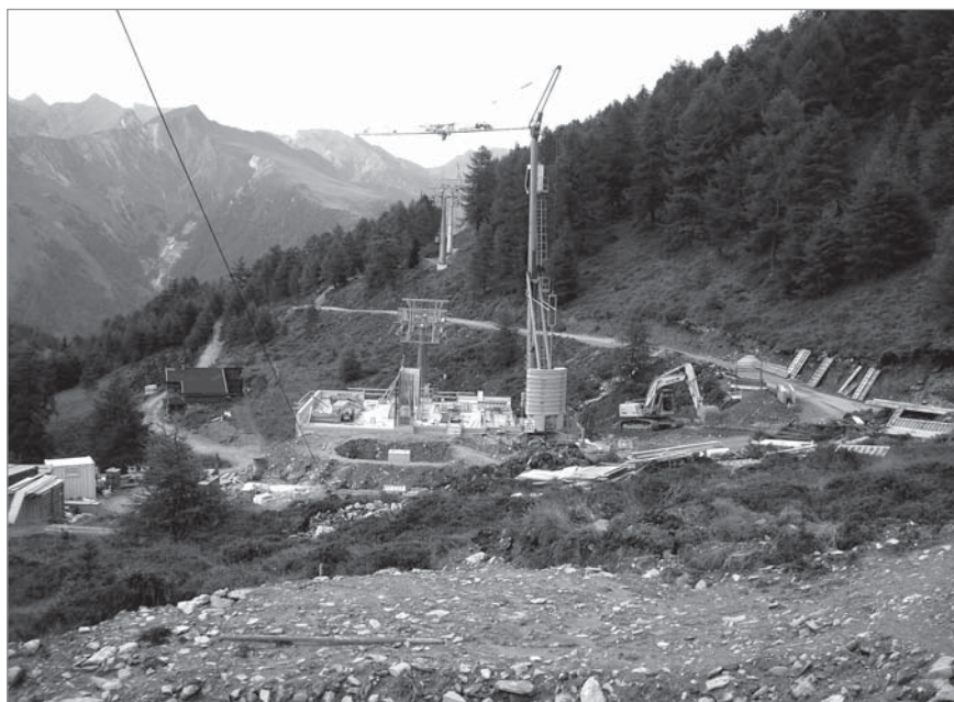
Mittelstation: Baumeisterarbeiten kurz vor dem Abschluss, ab Mitte August begannen die Montagearbeiten für den maschinellen Teil
