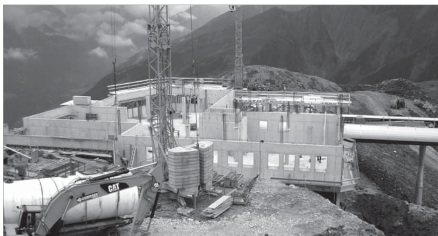
Die Baumaßnahmen an der neuen Schiverbindung schreiten zügig voran. 12. August 2008: Oberste Geschoßdecke bei der Bergstation ist erreicht, darauf wird eine Holz Glas Konstruktion für die Adlerlounge errichtet
