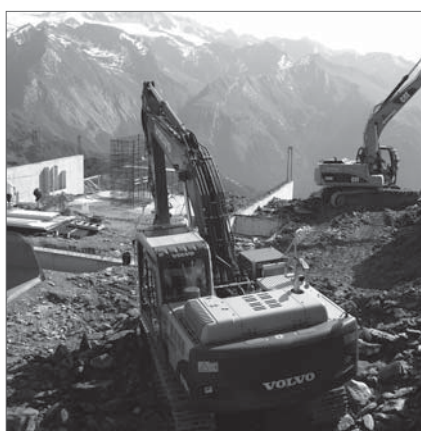
Großglocknerresort Kals/Matrei Baufortschritt
