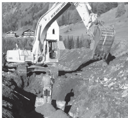
Gemeindekraftwerk Dorferbach - Baufortschritt Seite 14
