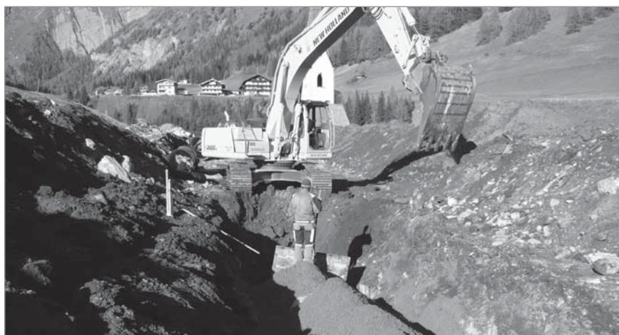
Rohrverlegung auf den Dorfer Feldern hinter St. Georg
