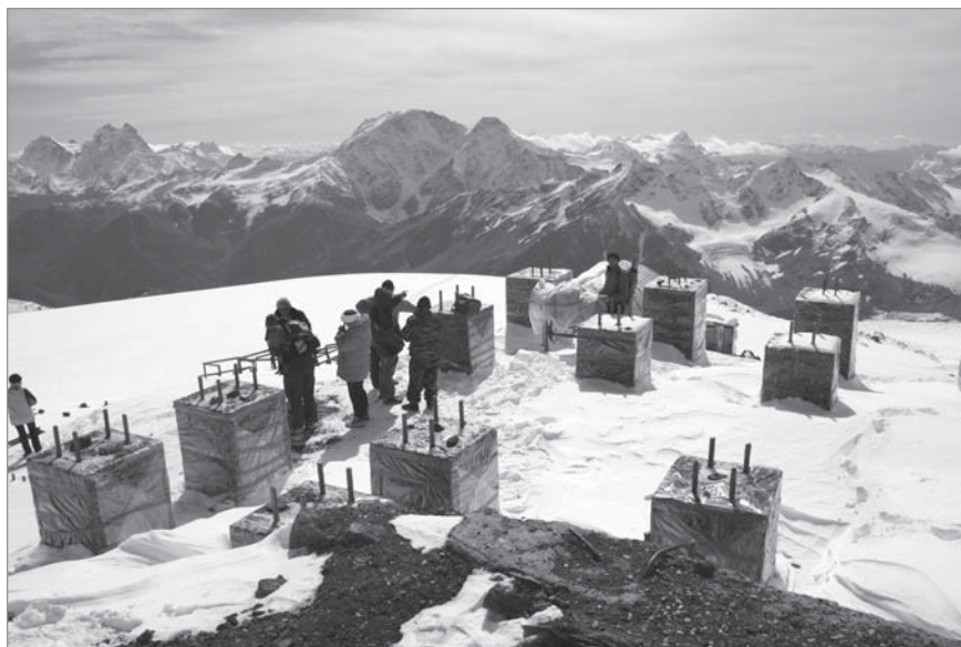
Die Betonfundamente der geplanten Hütte
