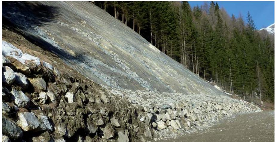
Hangsicherung durch Aufbringen und Verankerung von Gittern sowie Drainage
