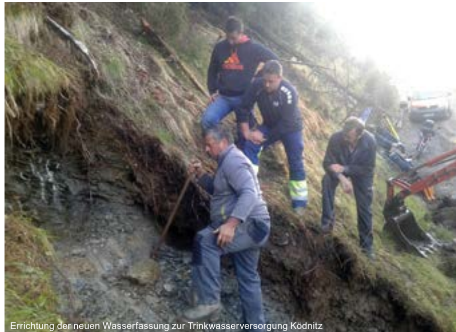
Errichtung der neuen Wasserfassung zur Trinkwasserversorgung Ködnitz
