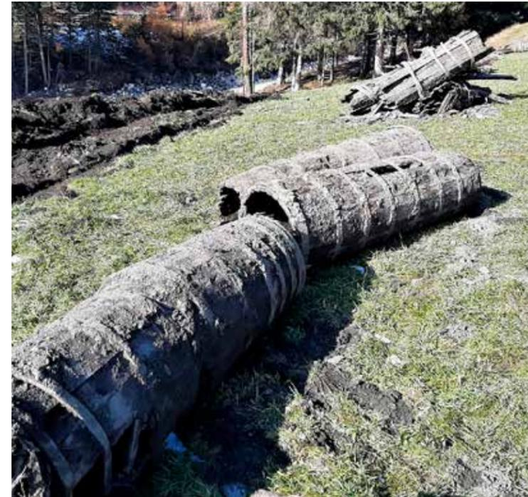
Gut erhaltenes Rohr aus Lärchendauben mit sieben zusammengenieteten und im Umfang genau an den Konusverlauf angepassten Eisenbändern. Eine wohl zeitaufwändige und präzise Handarbeit des Fassbindemeisters Heinz aus Oberlienz. Foto: Expa-Gruber
