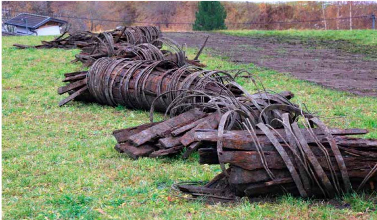
Nach fast 115 Jahren im feuchten Erdreich waren die hölzernen Druckrohre mit den Eisenreifen noch in erstaunlich gutem Zustand. Im Bild auch sichtbar der Turm des einstigen Krafthauses, von dem sich die Elektrofreileitungen verzweigten.
